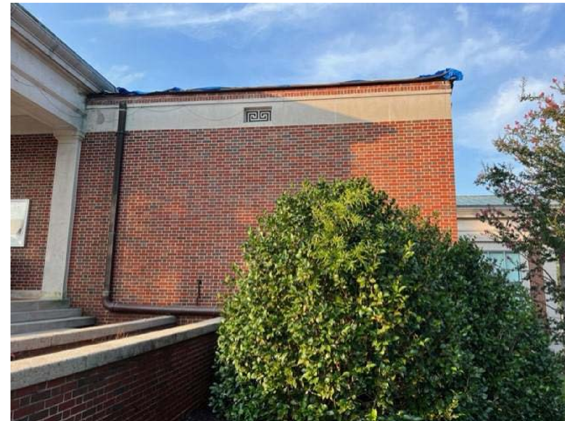
(D) REPOINT EXISTING BRICK VENEER.
